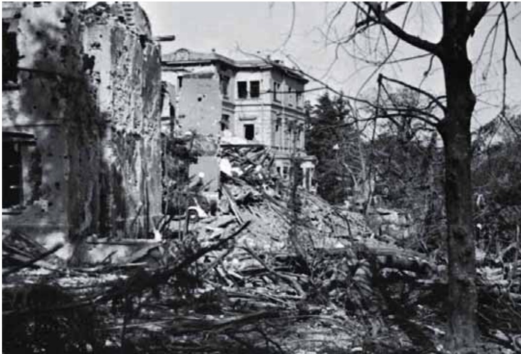
Gli effetti del bombardamento sugli edifici di Colle Campigli (foto di Uberto Vedani)
